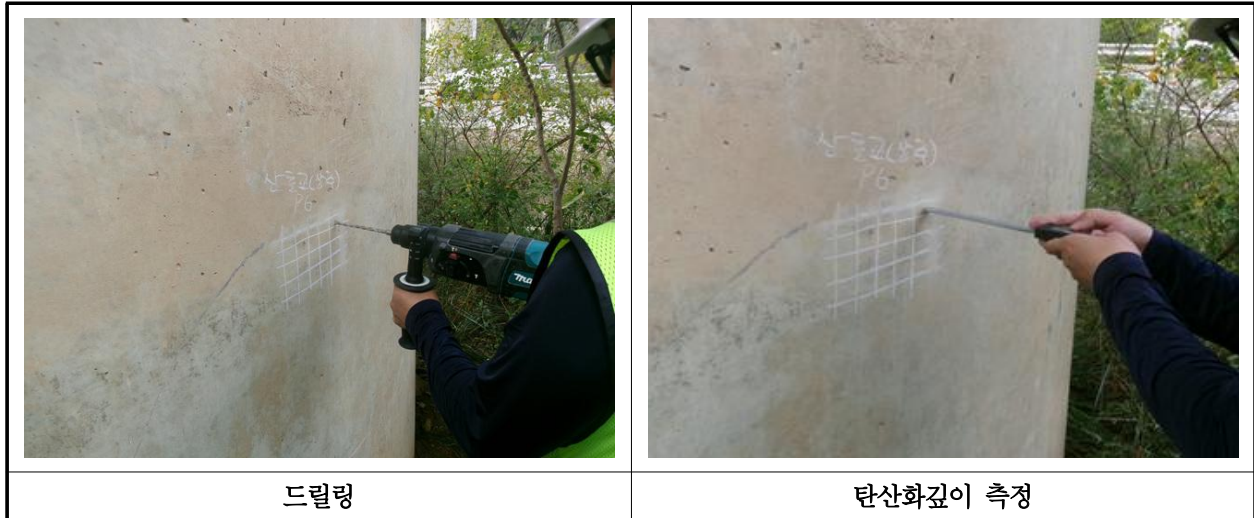
【사진 10.4.3】 탄산화 깊이 측정 현장사진
