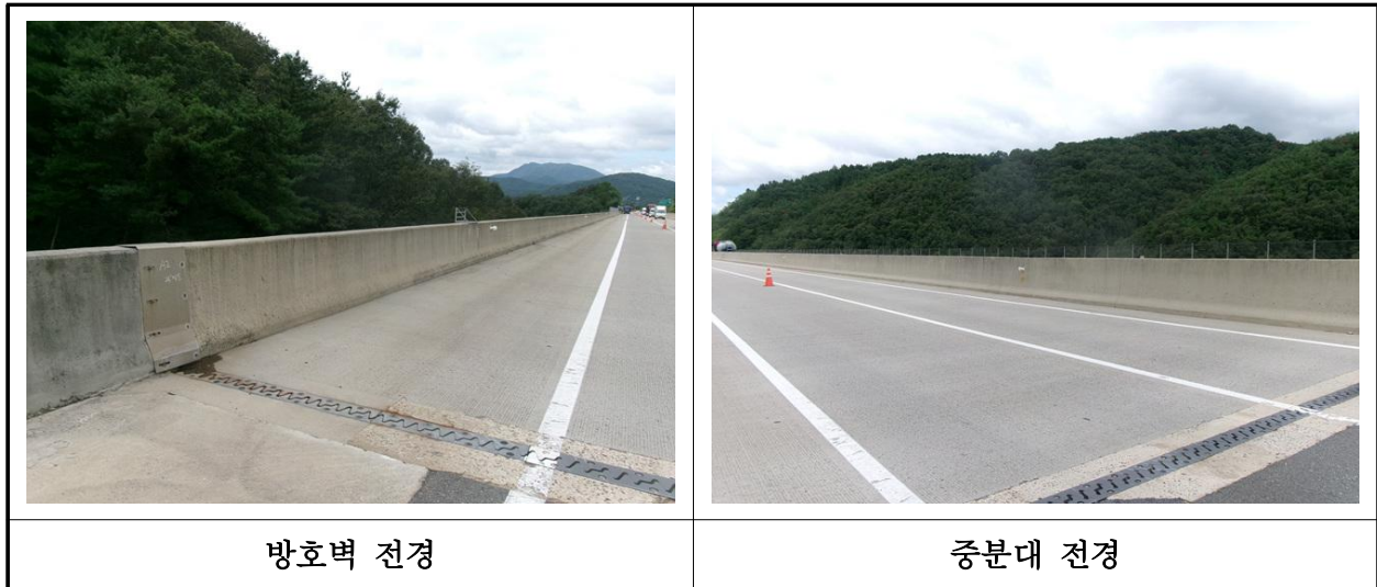
【사진 10.3.52】 방호벽 및 중분대 전경
