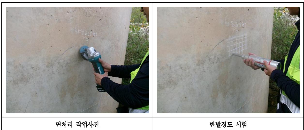
【사진 10.4.2】 반발경도시험 현장사진
