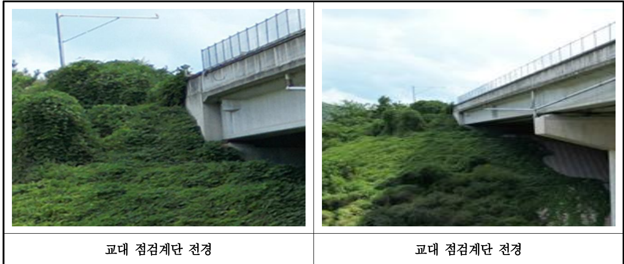
【사진 10.3.26】 교량 점검시설 전경
