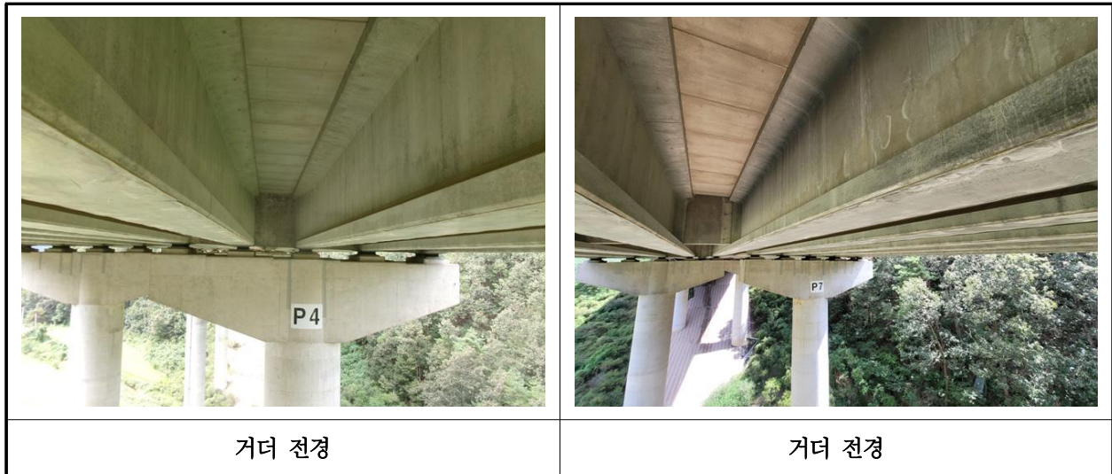
【사진 10.3.4】 거더 전경
