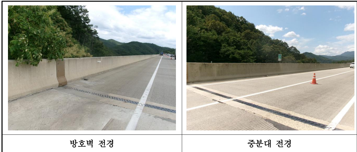
【사진 10.3.24】 방호벽 및 중분대 전경
