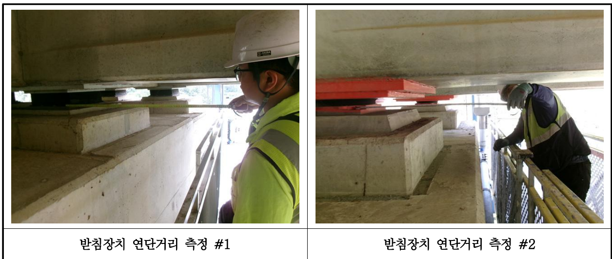
【사진 10.3.42】 교량받침장치 연단거리측정
