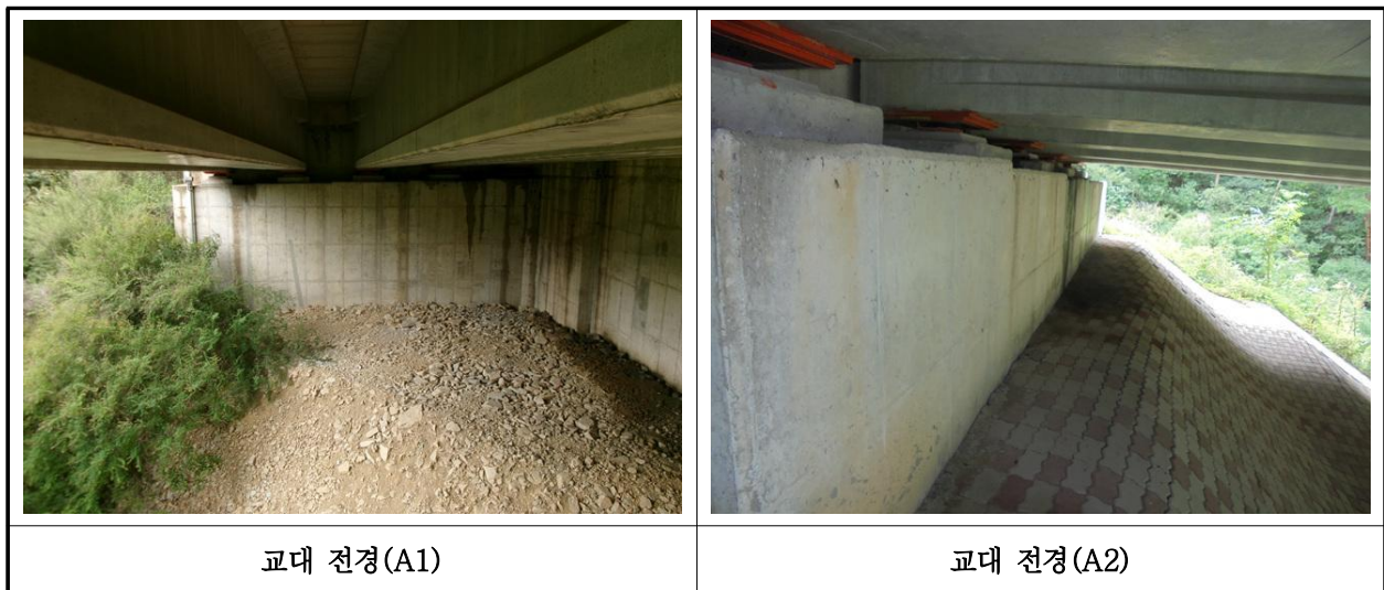
【사진 10.3.35】 교대 전경
