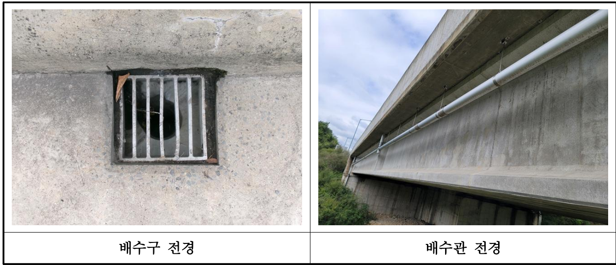
【사진 10.3.50】 배수시설 전경
