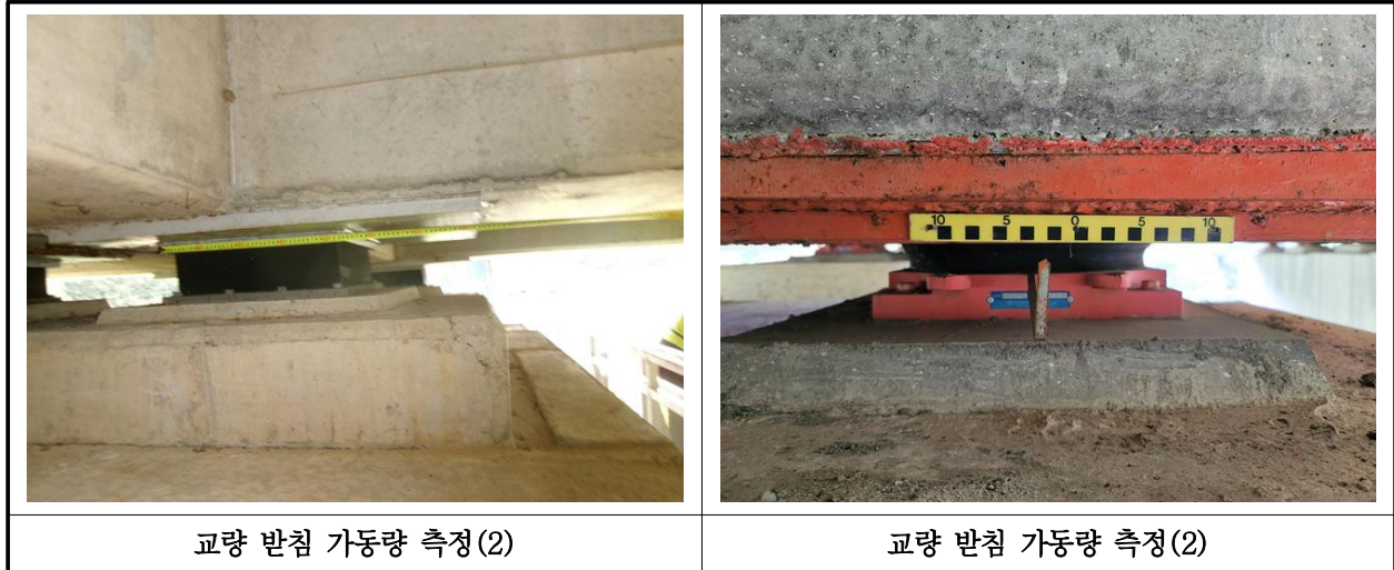
【사진 10.3.43】 교량받침 이동량 측정
