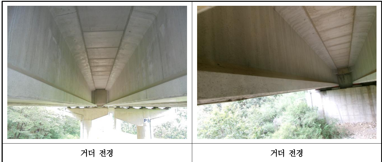
【사진 10.3.31】 거더 전경
