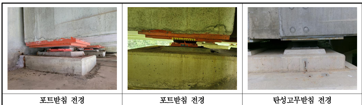
【사진 10.3.40】 교량받침 전경
