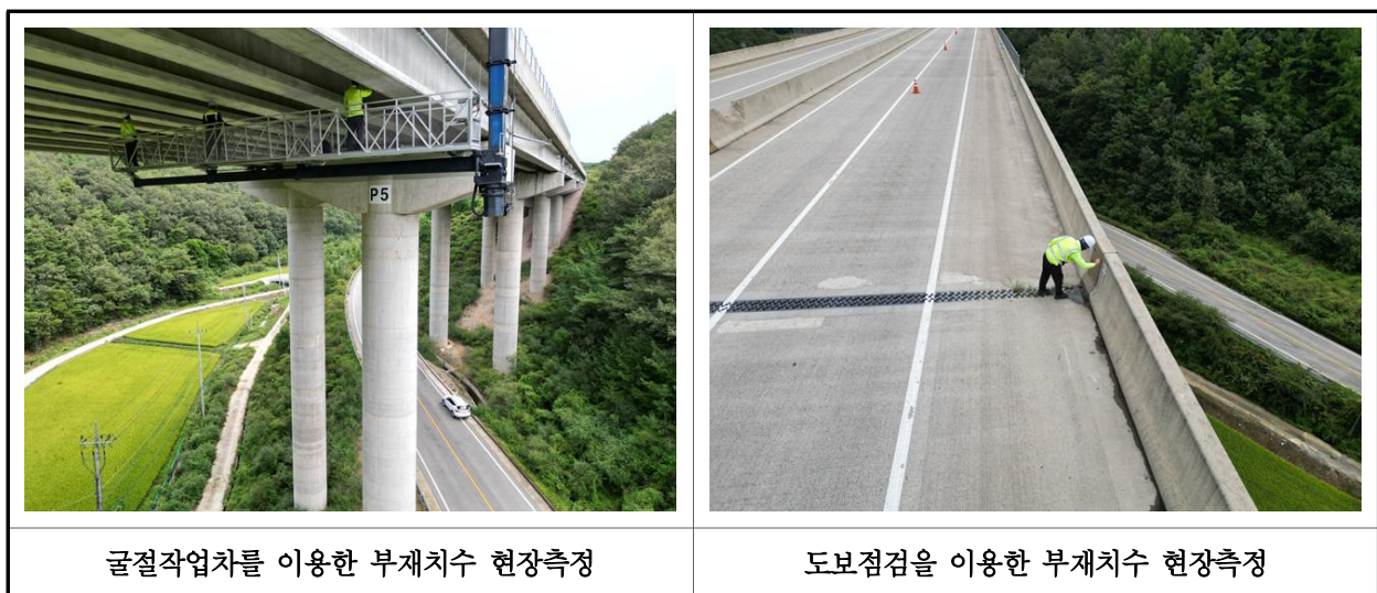
【사진 10.2.1】 부재 현장측정 전경
