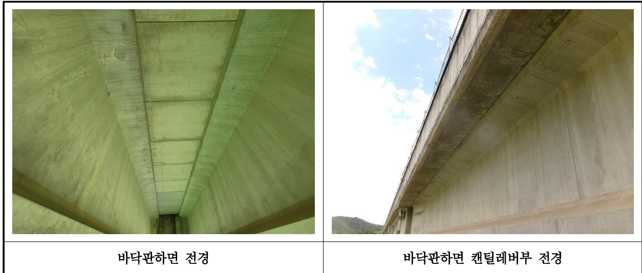
【사진 10.3.2】 바닥판하면 전경
