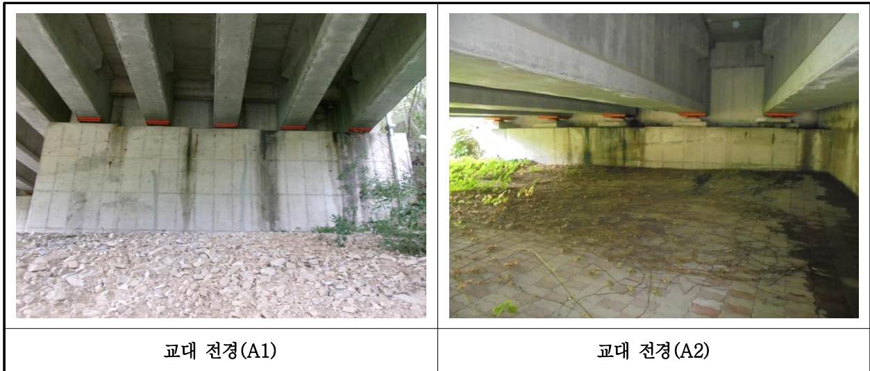
【사진 10.3.8】 교대 전경
