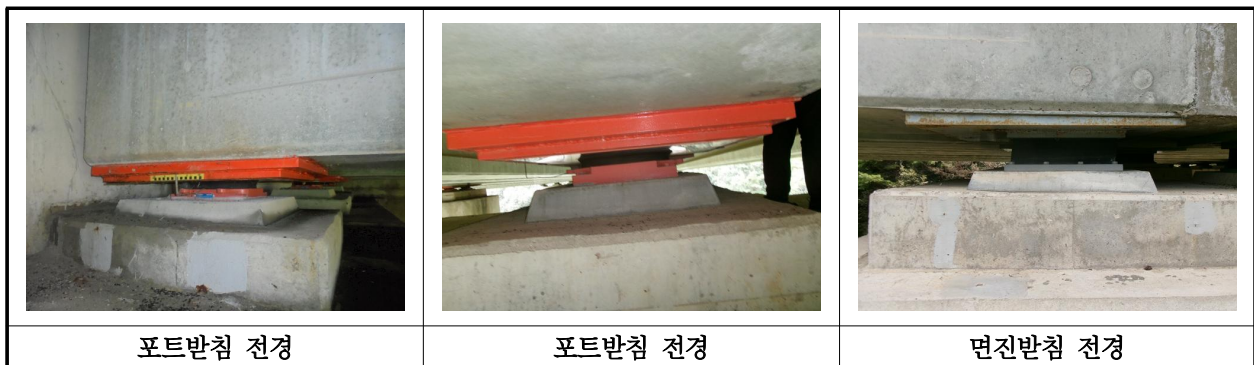
【사진 10.3.13】 교량받침 전경
