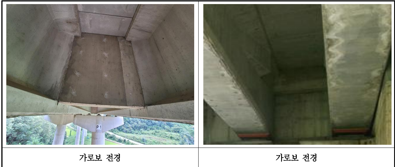
【사진 10.3.33】 가로보 전경
