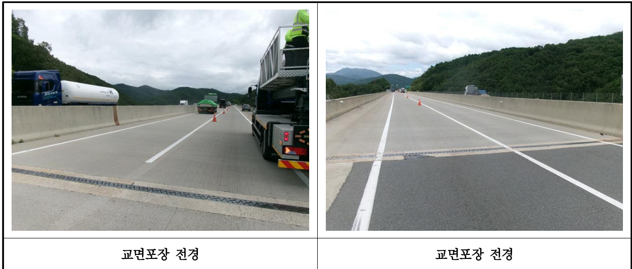
【사진 10.3.47】 교면포장 전경
