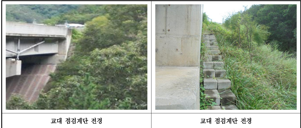
【사진 10.3.54】 교량 점검시설 전경
