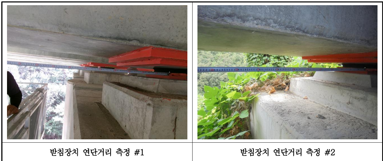
【사진 10.3.15】 교량받침장치 연단거리측정
