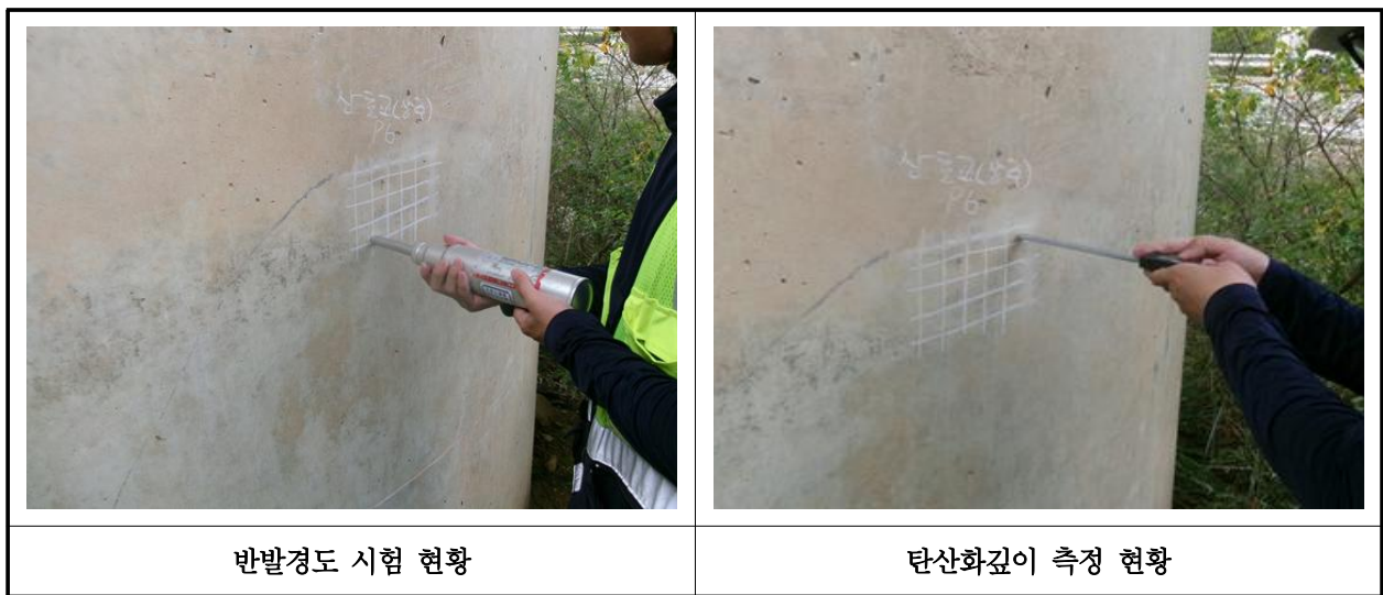
【사진 10.4.1】 콘크리트 내구성조사 현황
