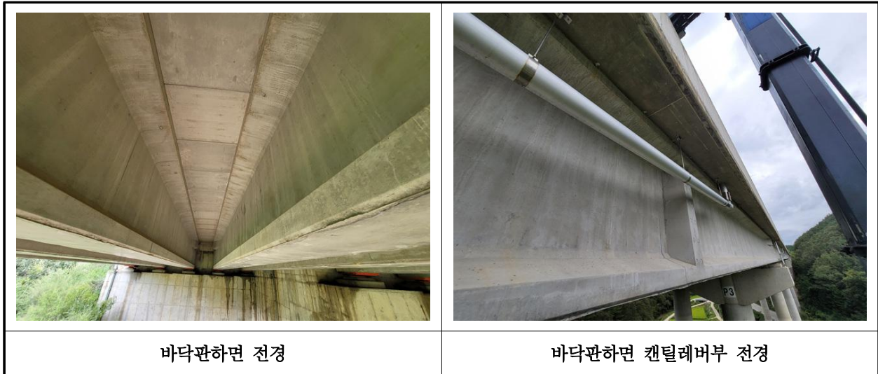
【사진 10.3.29】 바닥판하면 전경
