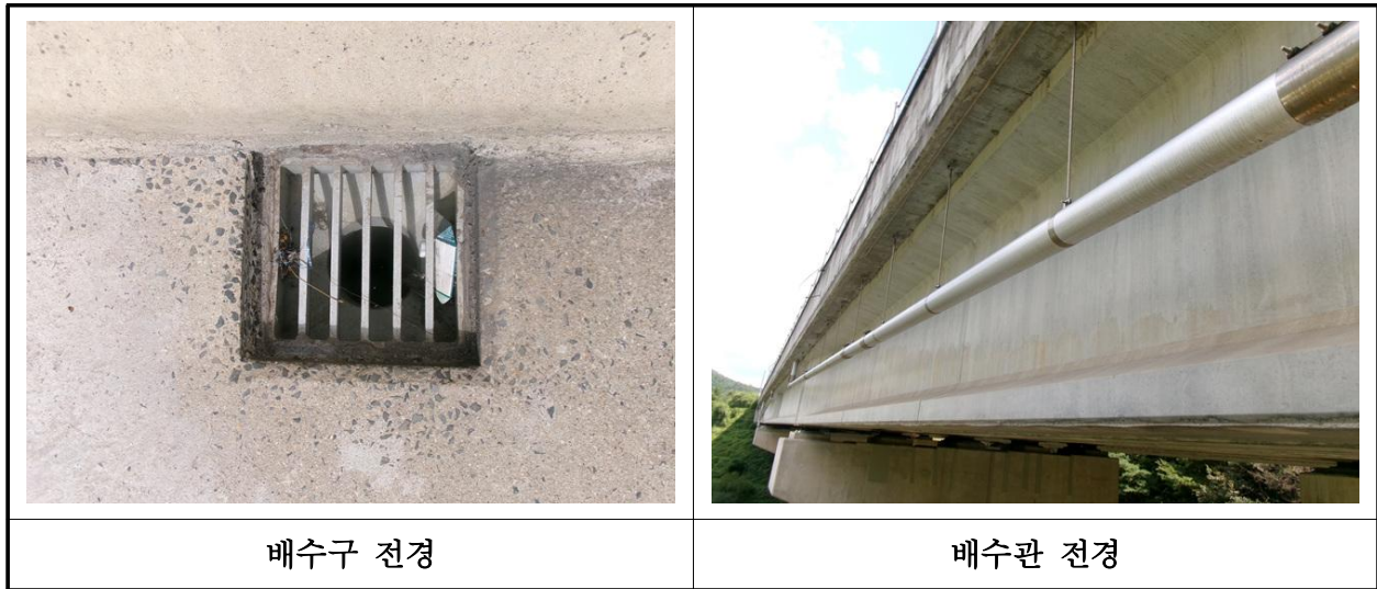
【사진 10.3.22】 배수시설 전경
